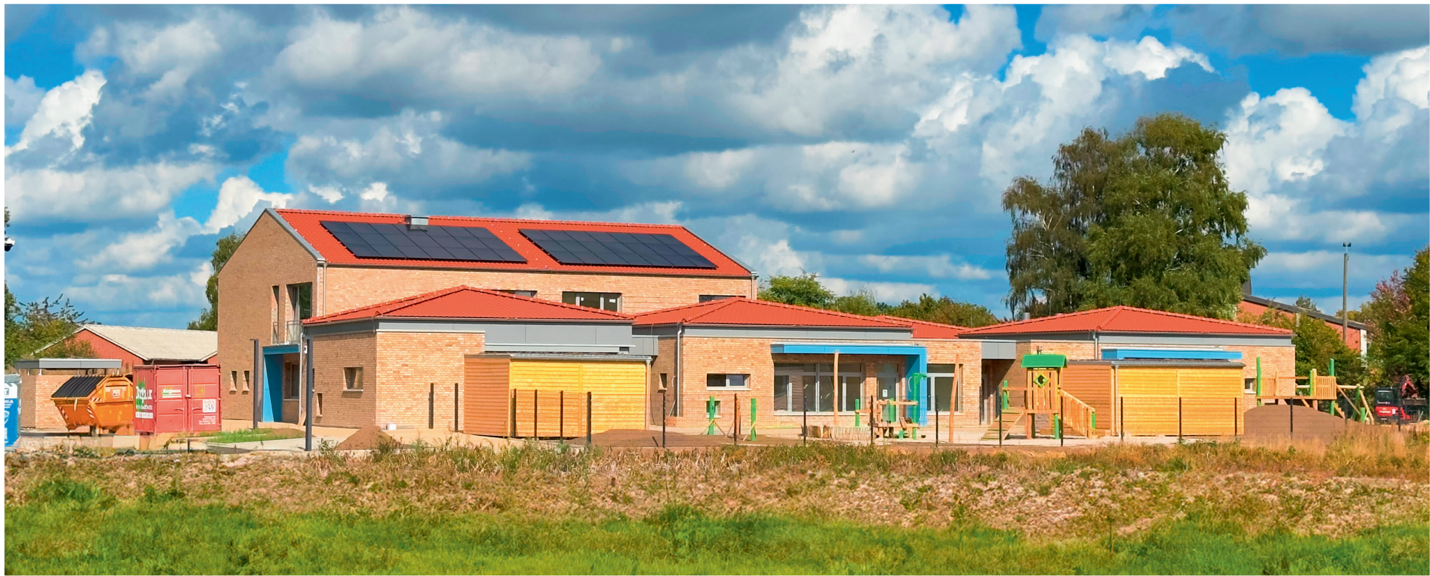
Direkt am Schul- und Sportgelände entstand die neue Kindertagesstätte.
