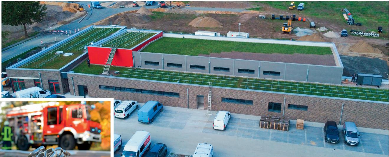
Das etwa 1500 Quadratmeter große Gründach speichert Regenwasser.
